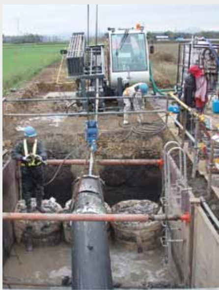
Japan: Der TERRA-JET 8522 S verlegt ein HDPE-Rohr DA 560 mm über 60 m.
