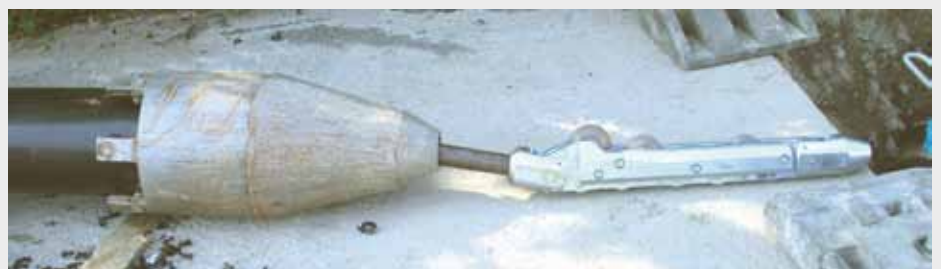
Mühlethurnen: Das neue Rollenmesser DN 100 mm mit Aufweitkonus Ø 324 mm und HDPE-Rohr DA 250 mm.
