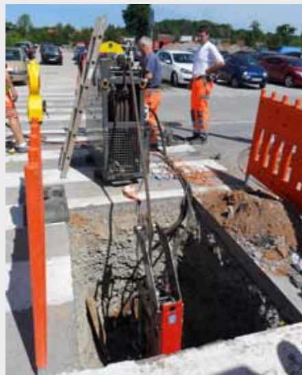
Crailsheim: Die automatische Seiltrommel X 400 rollt das Zugseil synchron zum Rohreinzug auf.
